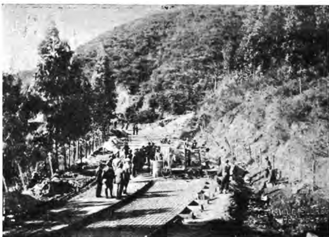
Imágenes n.ºs 57 y 58. Fotografías de la ceremonia de colocación de los primeros hormigones en el camino de Valparaíso a Casablanca.
