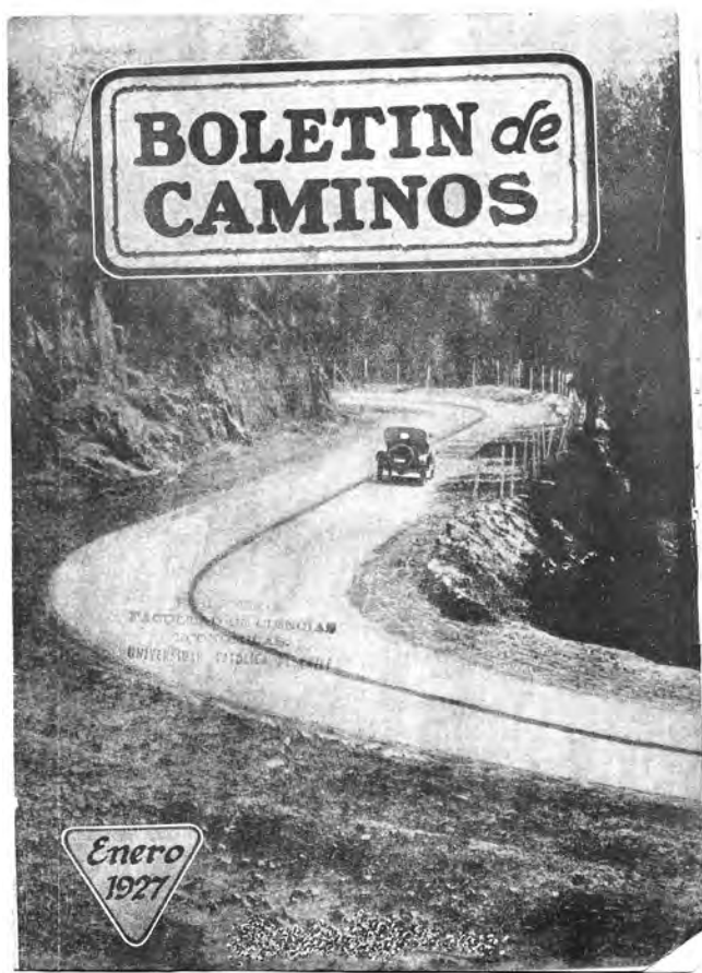
Imagen n.º 56. Primera sección del camino pavimentado entre Valparaíso y Casablanca. Fuente: Boletín de Caminos , vol. 1, n.º 1, enero de 1927.
