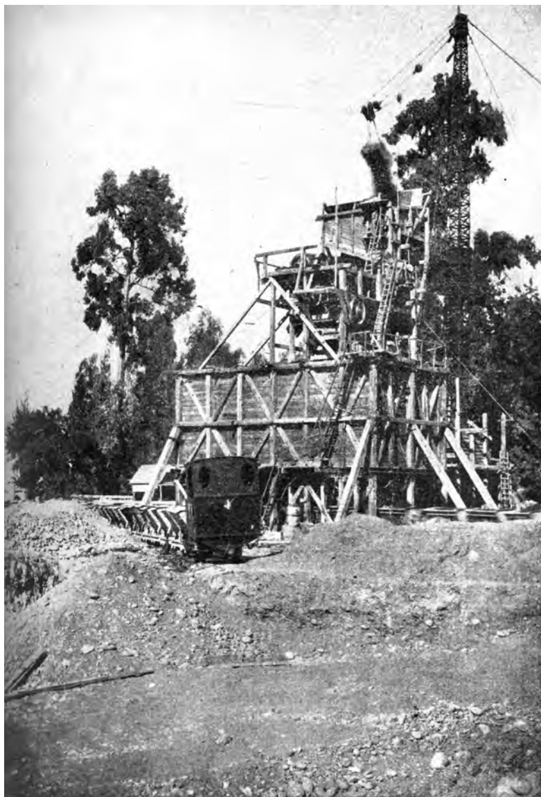
Imagen n.º 22. Camino de Santiago a Melipilla. Planta clasificadora en el kilómetro 7300 . Fuente: Revista de Caminos , abril de 1930.
