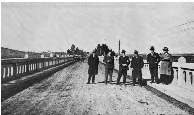
Imagen n.º 21. Un grupo de ingenieros visita las obras del puente Cauquenes. Fuente: Boletín de Caminos , septiembre 1928.
