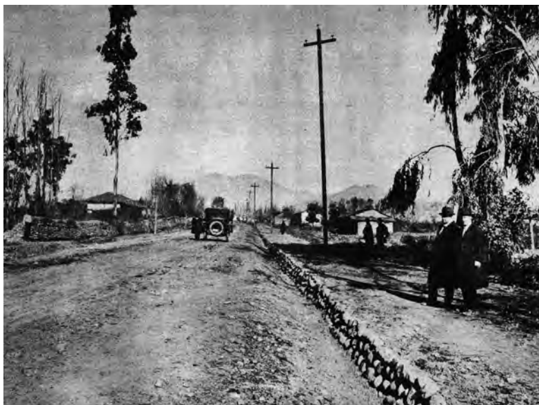
Imagen n.º 13. Inspección de las obras del camino de Santiago a Santa Rosa, 1921. Fuente: Boletín de Caminos , vol. 1, n.º 1, enero de 1927.
