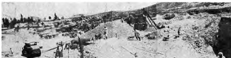
Imagen n.º 61. Una vista de las obras del camino entre Melipilla y Culiprán. Fuente: Boletín de Caminos , 1928.
