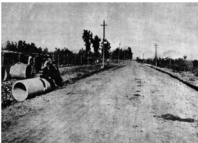
Imagen n.º 12. Camino de Santiago a Santa Rosa. Obras realizadas en 1921. Fuente: Boletín de Caminos , vol. 1, n.º 1, enero de 1927.
