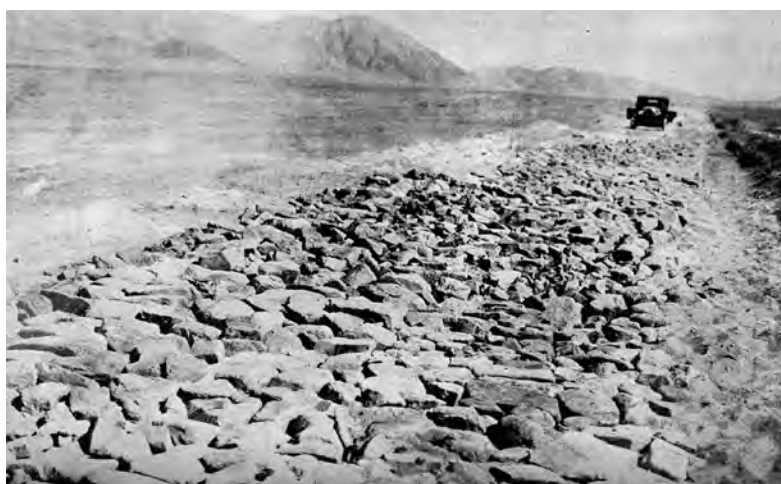
Imagen n.º 35. Obras de mejoramiento del camino entre Tocopilla y Antofagasta. Fuente: Boletín de Caminos , mayo de 1929.
