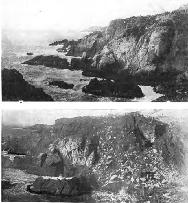
Imagen n.º 68. Voladura de rocas en el camino costero. Fuente: Auto y Aero , vol. 4, n.º 54, 30 de septiembre de 1917.
