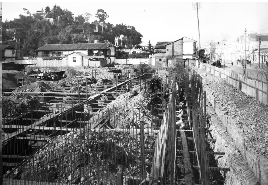
c. 1914, cimientos del edificio en construcción. Al fondo cerro Santa Lucía.
