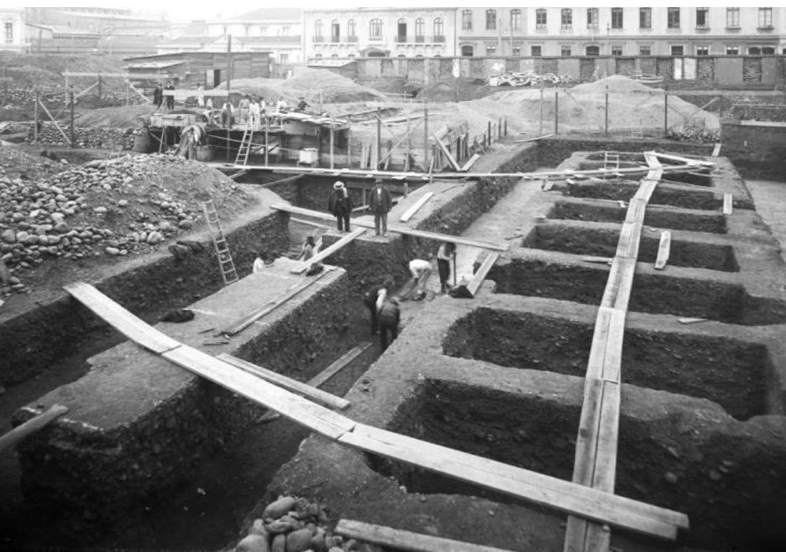
c. 1914, cimientos del edificio en construcción.
