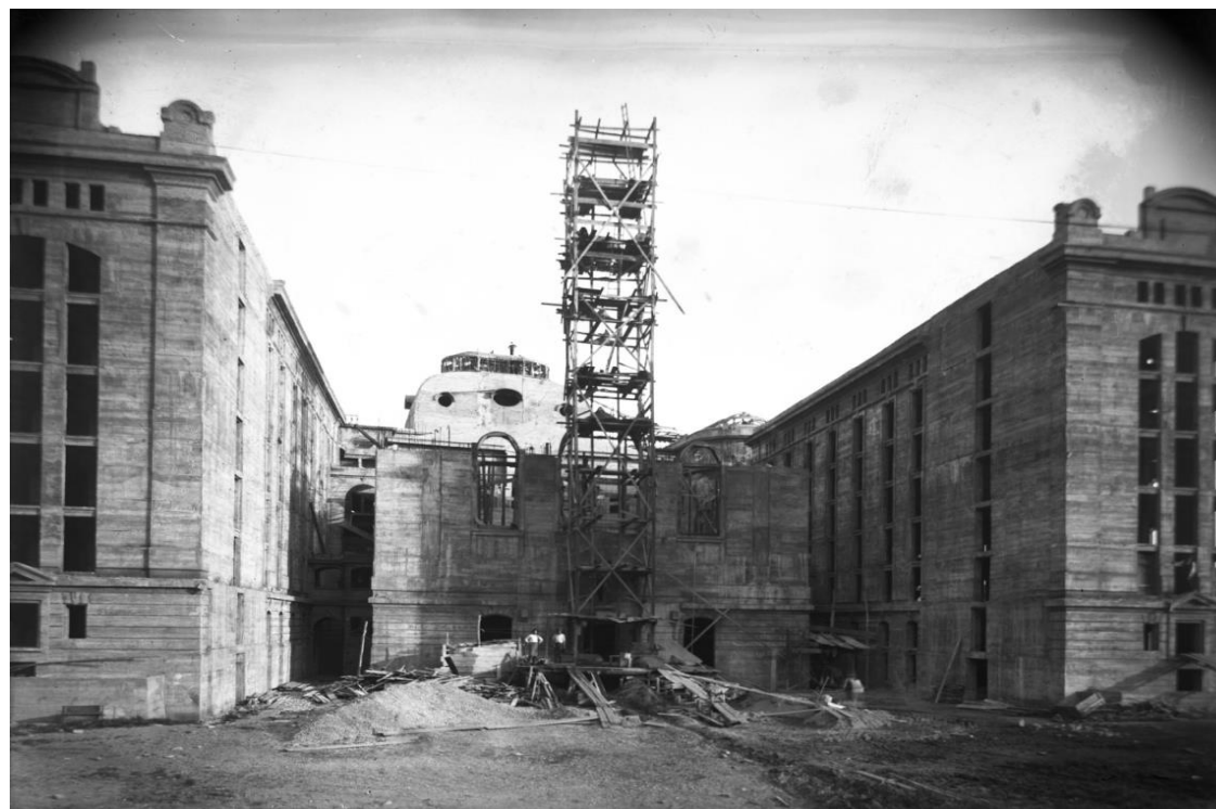
c. 1915, Biblioteca Nacional en construcción, se divisan andamios y edificios de almacenes.
