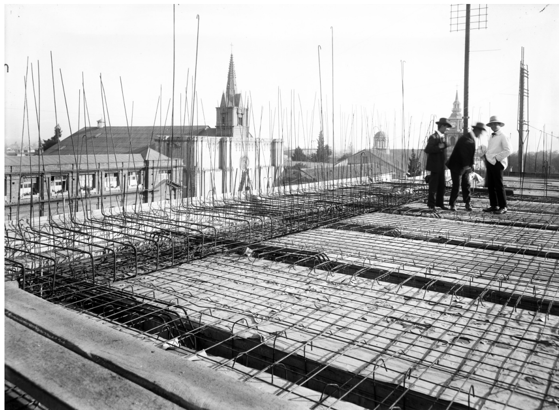
c. 1915, enfierradura del edificio en construcción.
