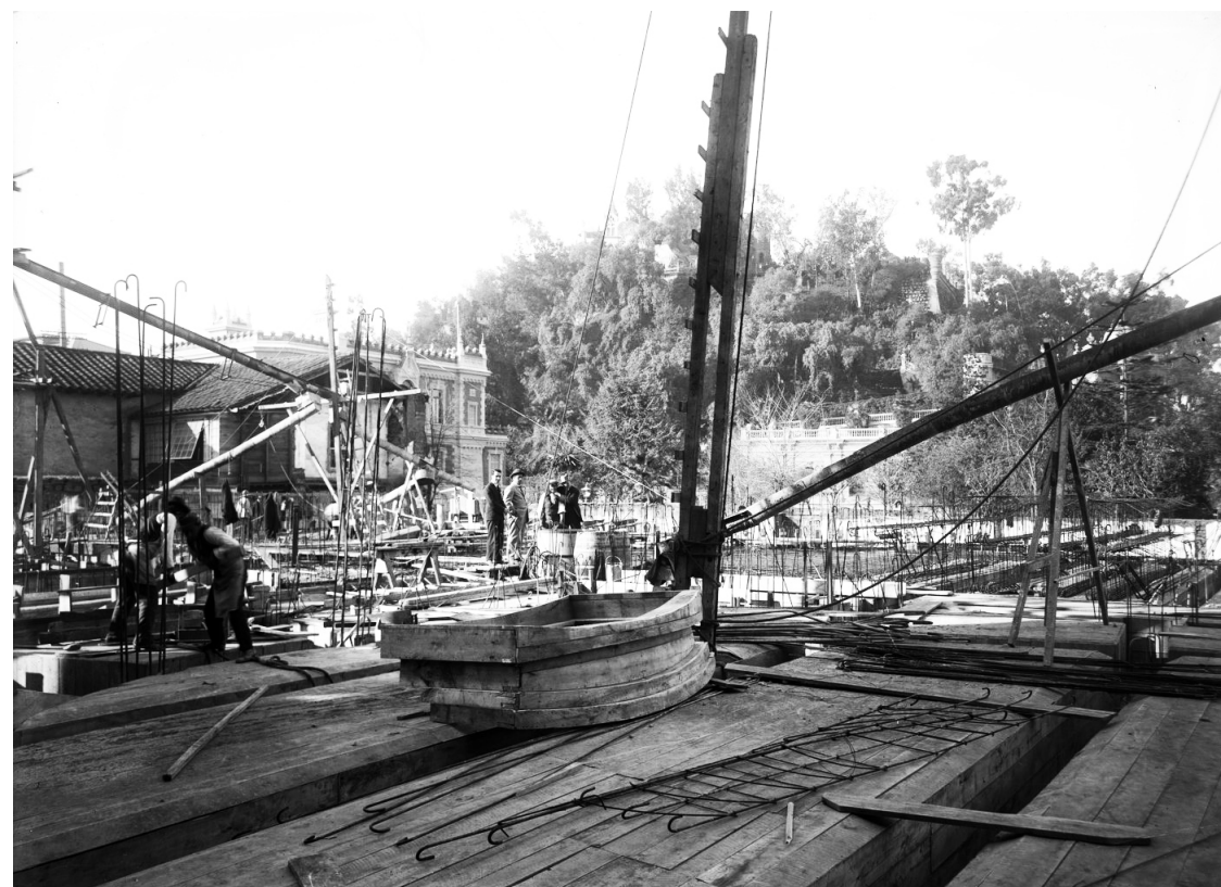
c. 1915, enfierradura del edificio en construcción.
